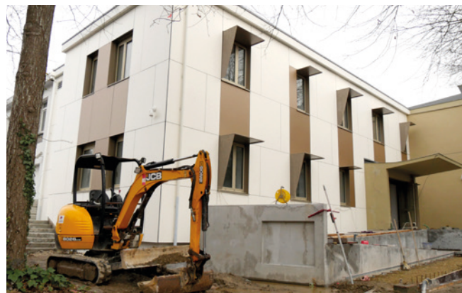
Future Maison de la prévention et de la tranquillité publique en cours de travaux
